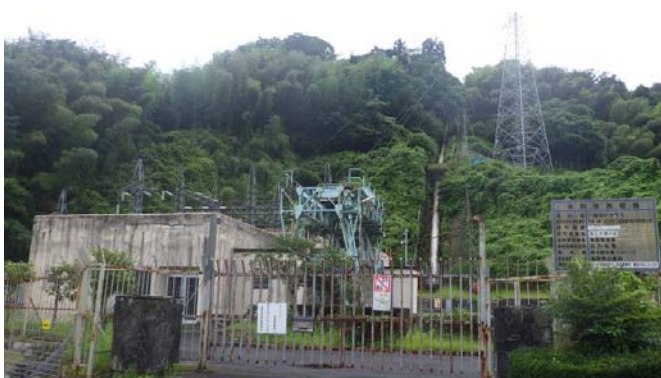
小鹿第二発電所
