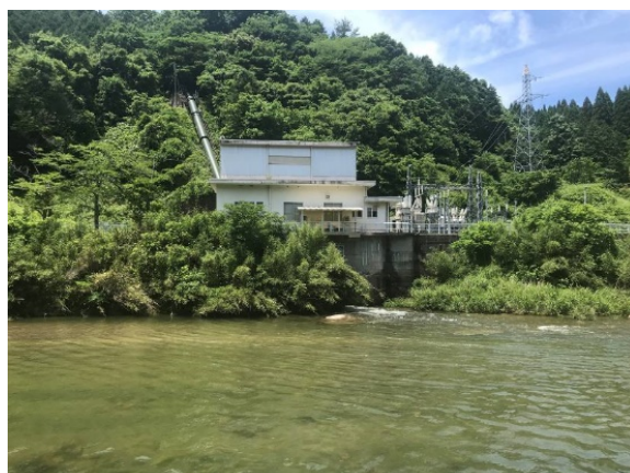
日野川第一発電所
