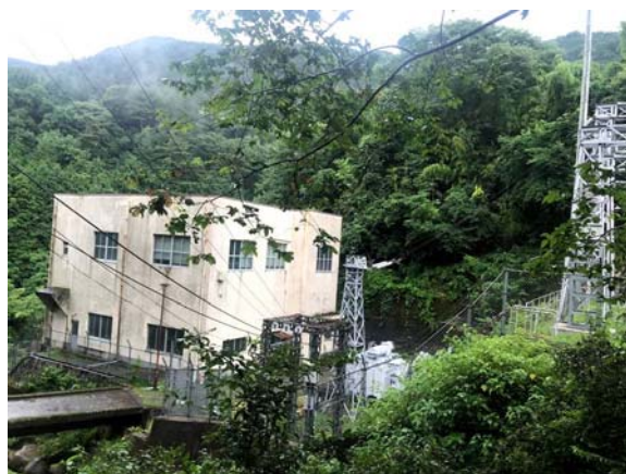
小鹿第一発電所
