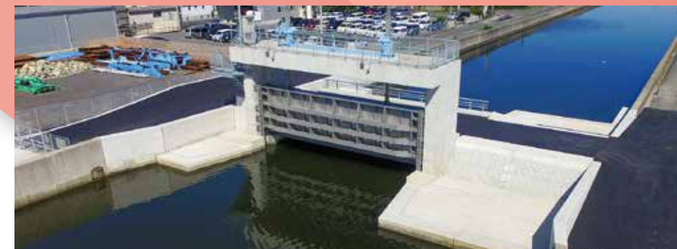
法勝寺川四ヶ村堰 改築工事
